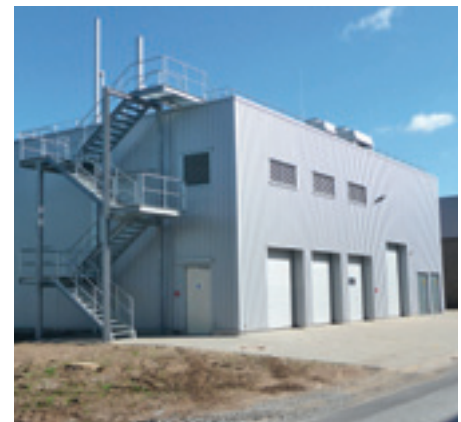
The new cogeneration unit at the »An der Autobahn« site in Gütersloh
